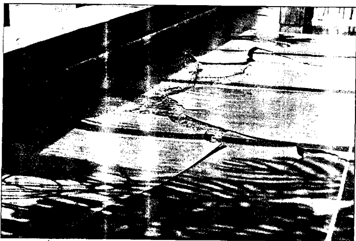
obr. 2 – Úplná destrukce podlahoviny vznikem trhlin a delaminací v důsledku úniku odpařitelných látek po vytvrzení
