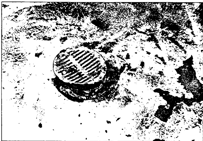
Obr. 4 – Destrukce podlahoviny u chybně navrženého a provedeného kanálového vstupu
